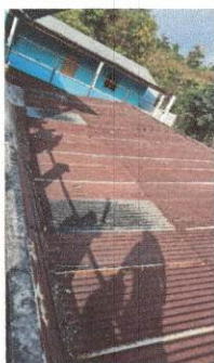
Foto 5: Sustitución de capote de lámina
