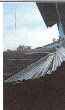
Foto 6: Cambio de lámina, reparación de captación y bajada de agua fluvial con tubo pvc "3"
